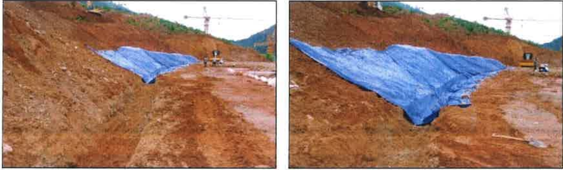
그림 23. 시공 중 임시배수로 및 비닐 Sheet 설치 중인 예
