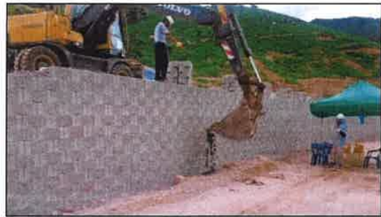
그림 21. Leveling 압석의 몰타르 처리
