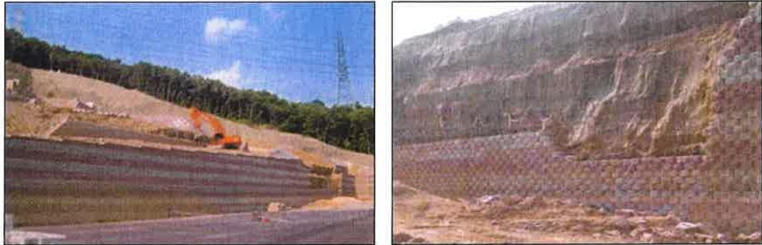
그림 9. 벽체상부파괴에 의한 진행성파괴
